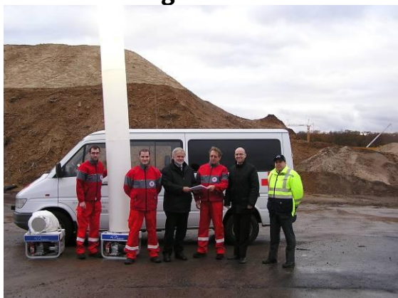
Dr. Peter Tauber mit DRK-Mitgliedern auf der Baustelle des Frankfurter Flughafens.
